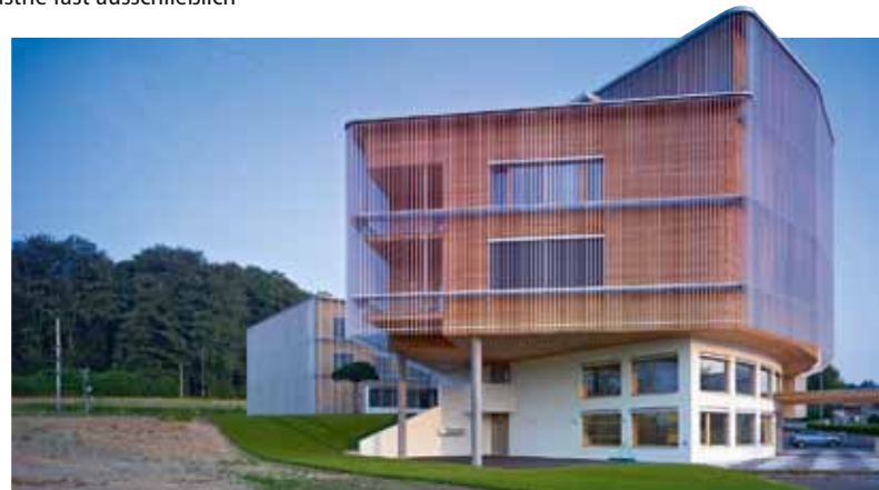
Büroneubau der Acutronic in der Schweiz: Holzbau-Ausführung stammte von Meiberger Holzbau, Architekt war Thomas Fliri
